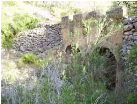
Puente de acceso a la Guarañonera, vista aguas arriba
