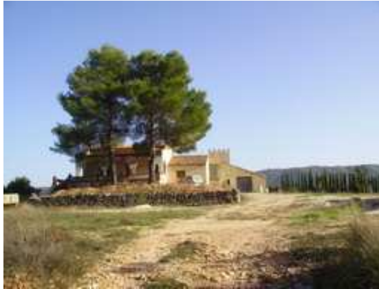
Vista de la casa de la Guarañonera desde el GR-7
